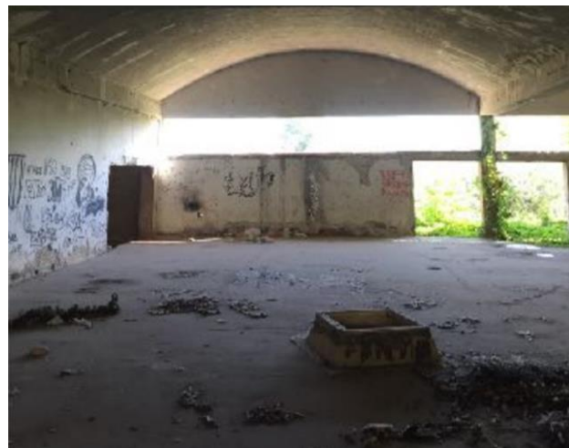
Ilustracija 1: Zatečeno stanje objekta na lokaciji
