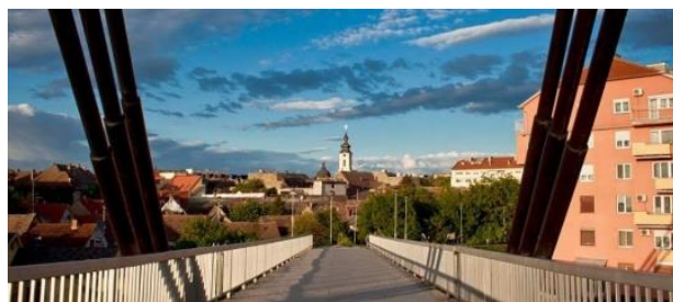
Слика 3. Мост Светог Иринеја
