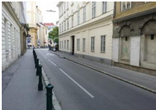
Slika 1. Postojeća zgrada – ulična fasada
