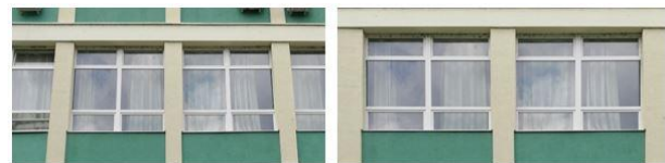
Slika 6. Neobrađena slika (lijevo) i obrađena slika (desno) S obzirom da su na jednom spratu jedne strane uglavnom prozori istog tipa, fotografisan je samo jedan, a zatim odgovarajućim podešavanjem razmjere i rotacije mape po X ili Y osi, ponovljen je prikaz onoliko puta koliko ima
