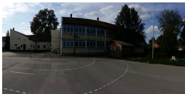
Slika 4. Dvorišna fasada objekta
