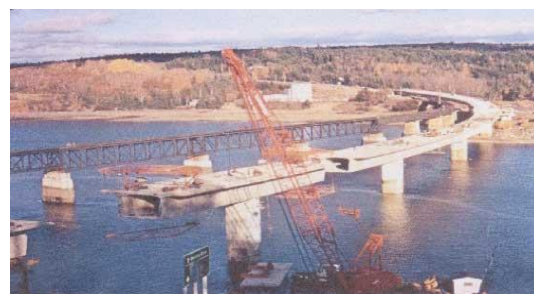
Slika 5. Montaža Bear River mosta (preuzeto iz [1])
