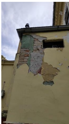
Slika 5. Otpadanje maltera sa fasade
