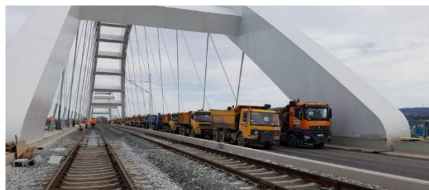
Slika 1. Ispitivanje probnim opterećenjem
