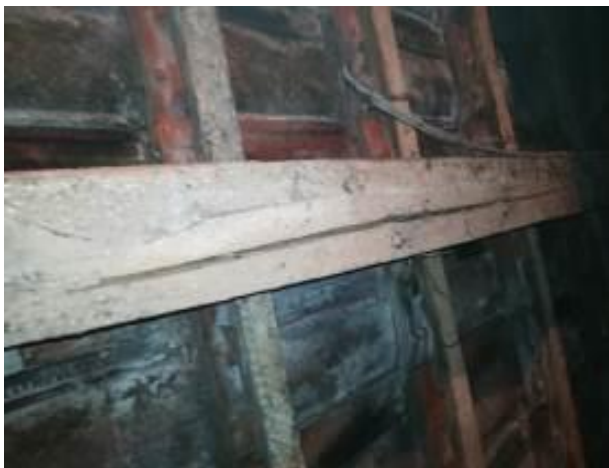
Slika 4. Drvena krovna konstrukcija
