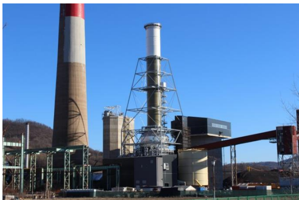
Slika 2. Postrojenje za ODG u izgradnji [1]
