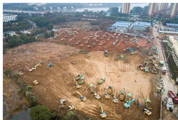
Slika 2. Izgradnja privremene ambulante u Vuhanu
