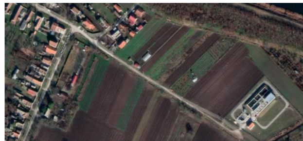
Sl. 2. Izgled prečištača otpadnih voda
