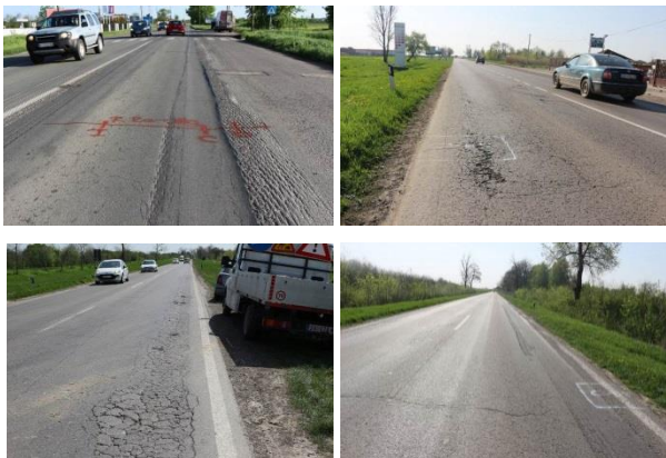
Slika 5: Karakteristična oštećenja
