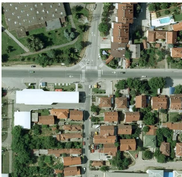
Slika 1. Položaj analizirane raskrsnice na uličnoj mreži grada Lekovca.
