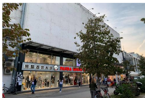
Slika 3. Izgled glavne fasade objekta
