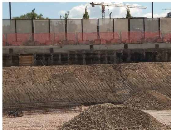
Slika 2.4. Izgled šipova sa yet groutingom
