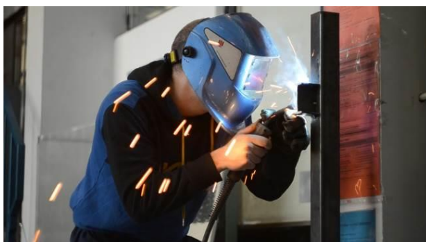
Slika 5.3 Zavarivanje konzolnih ispusta od IPE 80 profila
