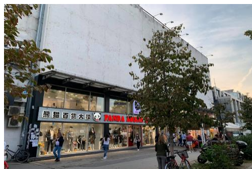
Slika 3. Izgled glavne fasade objekta
