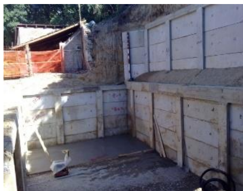
Slika 2.1. Izgled potporne konstrukcije Graditelj NS
