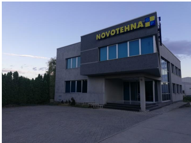
Слика 2. Изглед објекта
