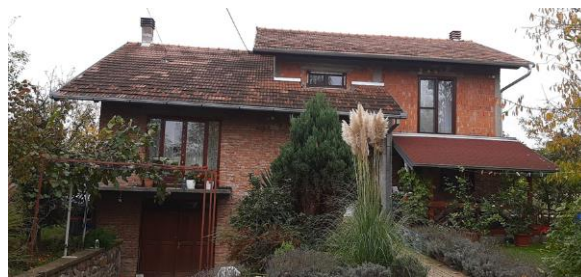
Slika 2. Izgled zapadne fasade objekta
