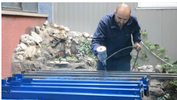
Slika 5.7 Završno farbanje elemenata konstrukcije
