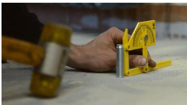
Slika 5.2 Postavljanje i podešavanje ankernih vijaka
