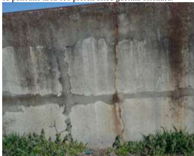
Slika 2. Prsline usled hidrauličkog skupljanja
