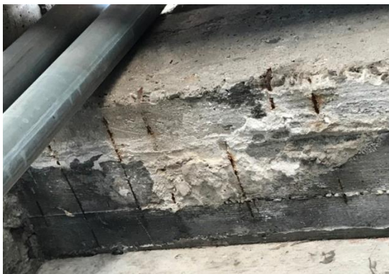
Slika 6 – Nedovoljna debljina zaštitnog sloja betona, vidljive korodirale uzengije na donjoj površini poprečne grede, nataložene naslage na donjoj površini
