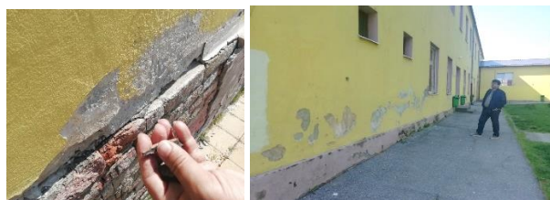
Slika 4. a) Trošan materijal, krunjenje elemenata opeke uslijed dejstva vlage, mraza, soli, oštećena i dotrajala hidroizolacija, b) Otpadanje, guljenje i ljuštenje maltera i boje sa fasadnih zidova uslijed djelovanja kapilarne vlage
