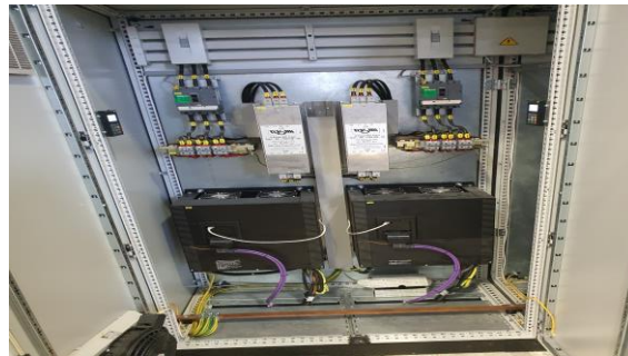
Slika 5. Frekventni pretvarači RX2 u elektro ormanu
