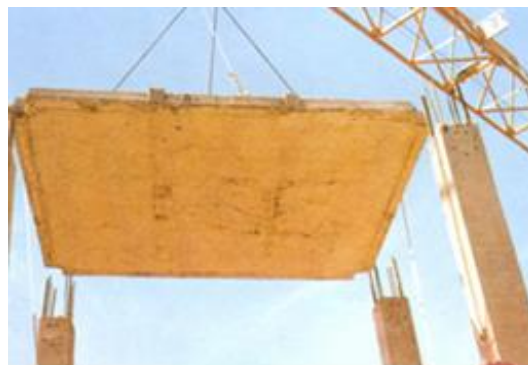
Slika 3. Montaža elemenata IMS sistema [8]
