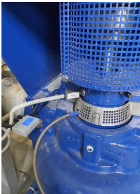
Slika 4. Pt100 senzor na ležaju motora
