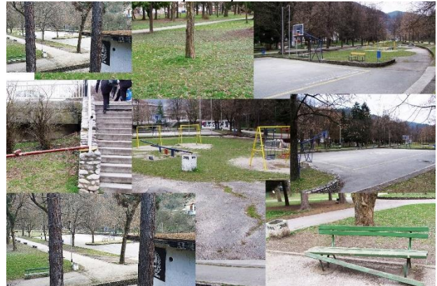
Slika 6. Fotografije postojećeg stanja
