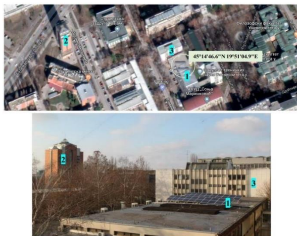
Slika 2. Lokacija FN elektrane FTN1 i izgled ravnog krova na kom su postavljeni paneli [14]
