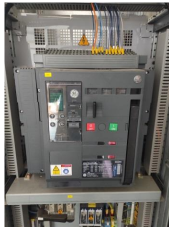
Slika 2. Spoljašni izgled vazdušnog prekidača snage
