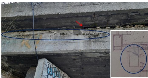
Slika 12. Pukotina na mestu nepovezanih slojeva betona u zidu kanala za odvodnjavanje atmosferskih voda u sklopu glavnog nosača
