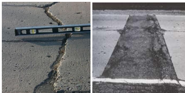
Слика 3. Слегање на попречној пукотини и закрпа [1]
