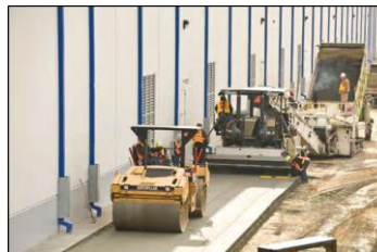
Слика 1. Уградња уваљаног бетона финишером и ваљком [2]
