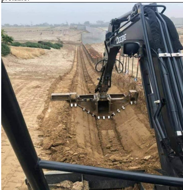
Slika 3. Kopenje kanala specijalno profilisanom kašikom
