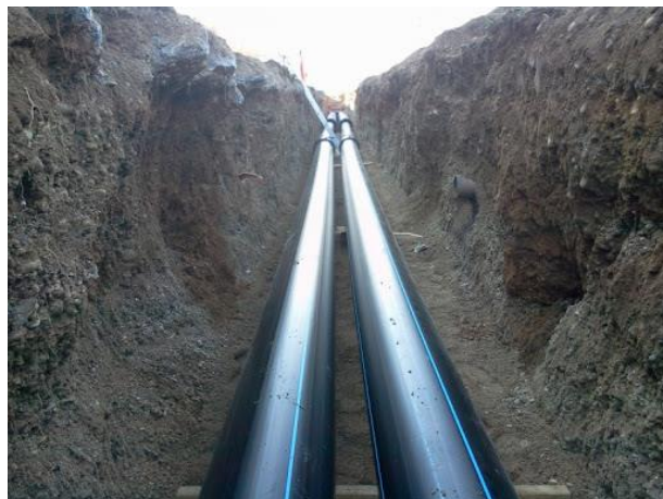
Slika 4. Polaganje HDPE cevi
