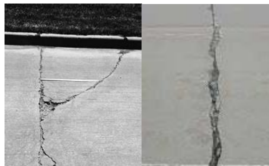
Слика 1. Угаона и попречна пукотина [1]
