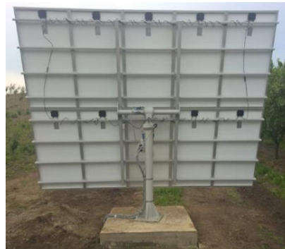
Slika 7. Prikaz noseće konstrukcije za 10 FN panela
