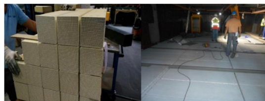
Slika 4 Katalizatorski elementi pre i nakon ugradnje [9]
