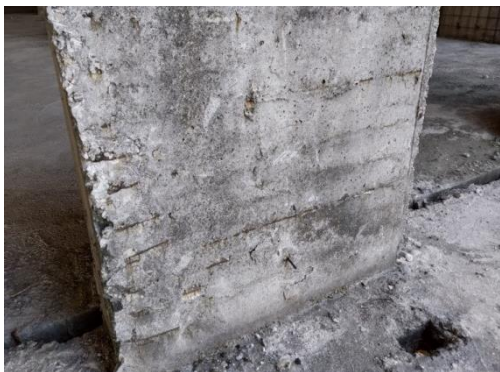
Slika 5 – Ljuskanje i otpadanje betona usled bubrenja korodirale horizontalne armature na unutrašnjoj strani platna (zidno platno)
