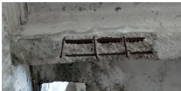
Slika 8 – Otpadanje zaštitnog sloja i korozijska armatura rebara, tragovi slivanja vode i biološka korozijska oko otvora na korubi
