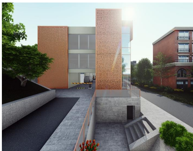
Слика 5. Приказ источне фасаде објекта
