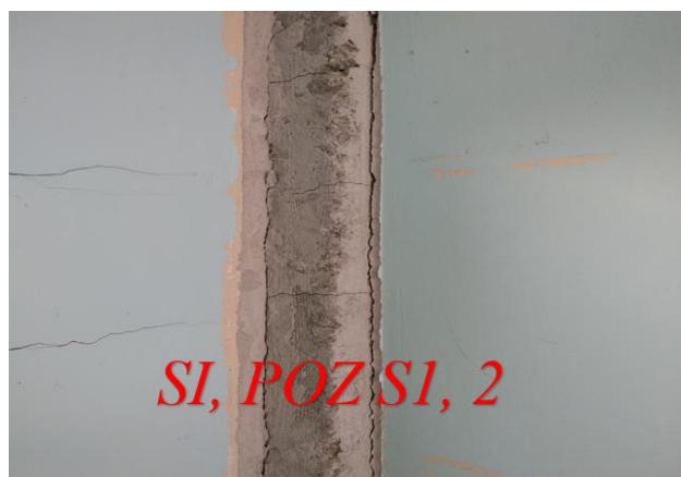
Slika 11. Oštećenje armiranobetonskog stuba na prvom spratu – SI, POZ S1, 2, otpadanje maltera i horizontalne pukotine, zbog prekoračenja čvrstoće betona na zatezanje
