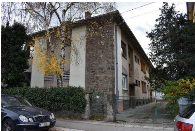
Slika 5. Izgled objekta sa severo-zapadne strane.
