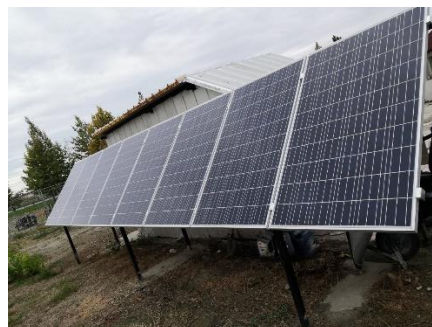
Slika 5: Fotonaponska elektrana na zemlji Fotonaponske elektrane montirane na objekat su najprisutniji oblik elektrana na maloj skali, bilo da su u pitanju domaćinstva, poslovni objekti ili industrijski objekti. Najviše ih ima u zemljama sa visokim životnim standardom gde ovakvi projekti ne predstavljaju veliku investiciju a izuzetno su isplativi zbog visoke cene električne energije, konkretno u SAD, Japanu i Nemačkoj.
