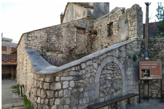
Slika 3. Odabrani objekat za rekonstrukciju [6]
