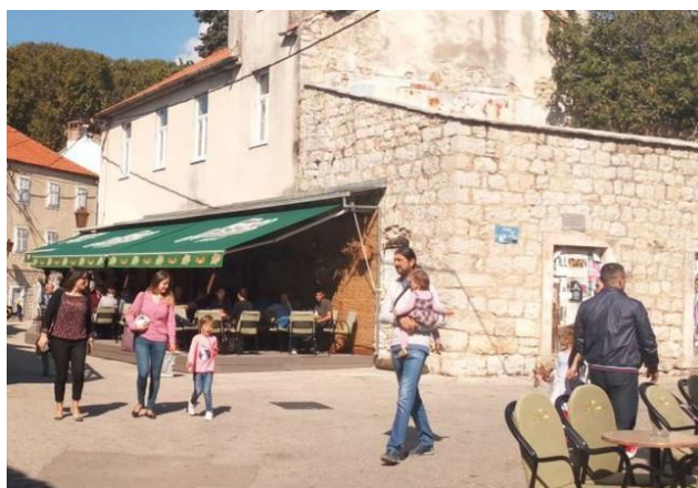
Slika 2. Odabrani objekat za rekonstrukciju [5]
