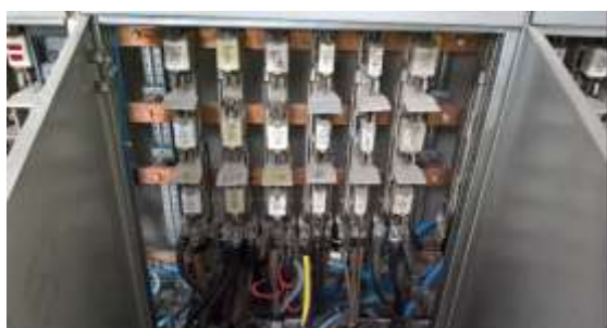
Слика 7. Прикључење сонди на кабловски извод за дубинску клипну пумпу
