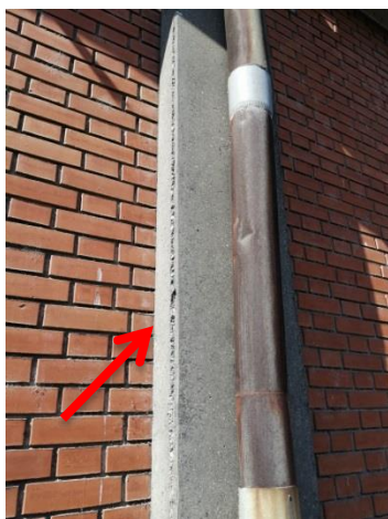
Slika 3 – Geometrijska imperfekcija AB stuba
