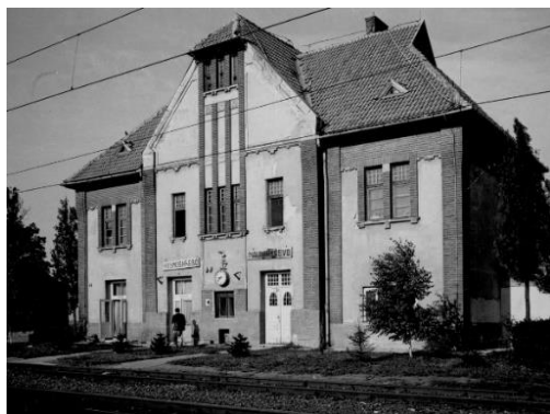
Slika 1. Izgled železničke stanice iz arhive [3]
