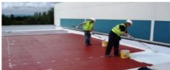
Slika 4. Nanošenje Sikalastic premaza
