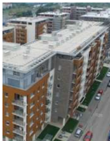
Slika 1. Ravan krov na zgradama
