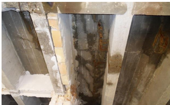
Slika 8. Oštećenja ploče
