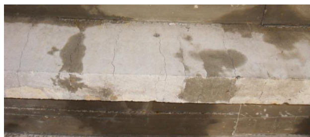
Slika 7. Prsline usled savijanja grede
