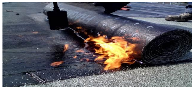
Slika 3. Postavljanje trake Kondora P-4
