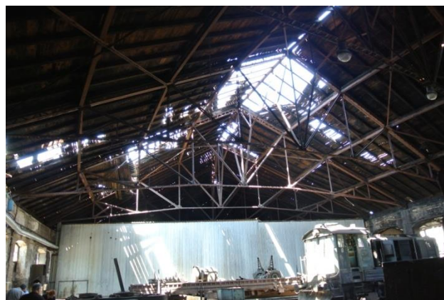
Slika 3. Unutrašnji prostor objekta ložionice [3]
