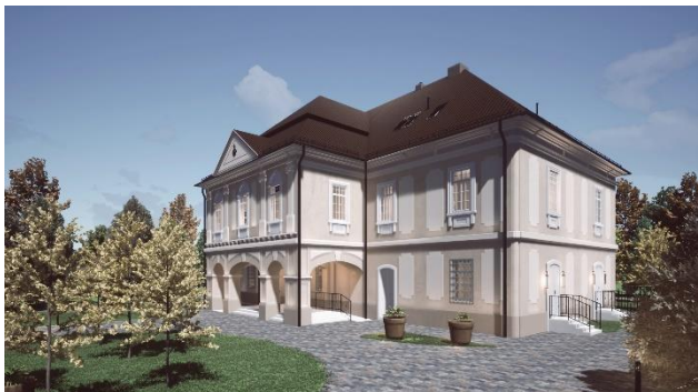
Slika 3. Ambijentalni prikaz revitalizovanog kompleksa
