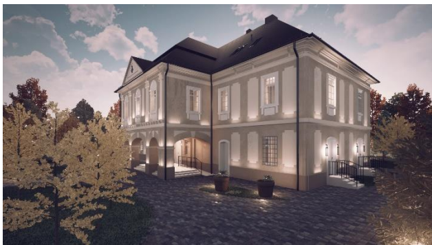
Slika 1. Ambijentalni prikaz revitalizovanog kompleksa
