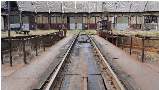
Slika 1. Objekat Ložionice sa okretnicom
