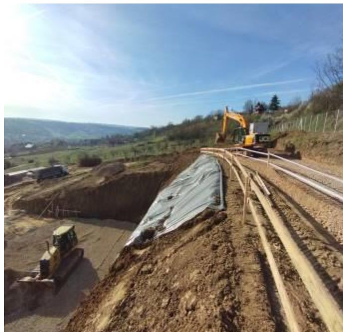
Slika 3. Izrada radnog platoa
