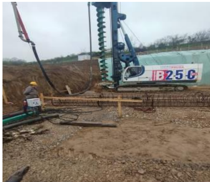
Slika 4. Bušenje šipova
