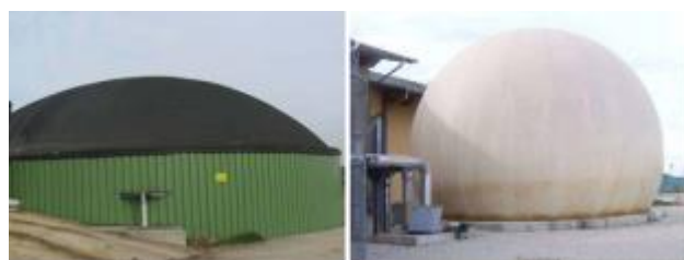
Слика 3.2: Складиштење биогаза на ниском притиску у а) гасној хауби изнад ферментора; б) ваздушном јастуку са заштитном мембраном [2]
