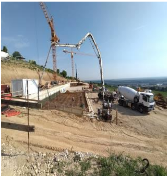
Slika 5. Izrada temeljne konstrukcije
