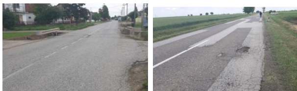
Slika 4: Karakteristična oštećenja
