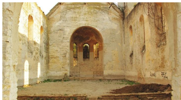
Slika 5. Unutrašnjost crkve - jednobrodna bazilika sa jednodijelnim oltarskim prostorom
