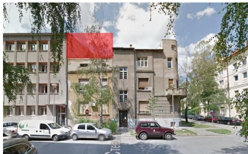
Slika 4. Prostor predviđen za nadogradnju
