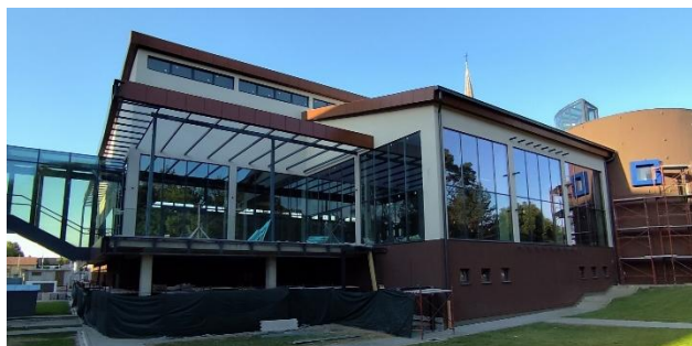
Slika 1. Spoljašnja fasada kompleksa bazena
