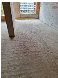
Слика 13. Седање бетона, АБ плоча
