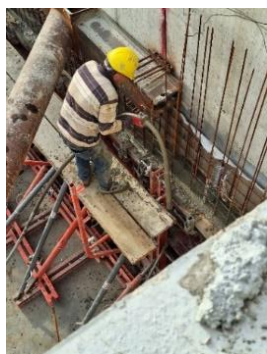
Слика 9. Извођење радова на бетонирању вертикалних АБ елемената
