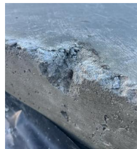
Слика 6. Механичка оштећења
