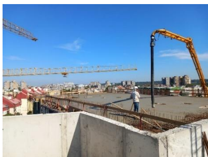
Слика 8. Извођење радова на бетонирању АБ плоча
