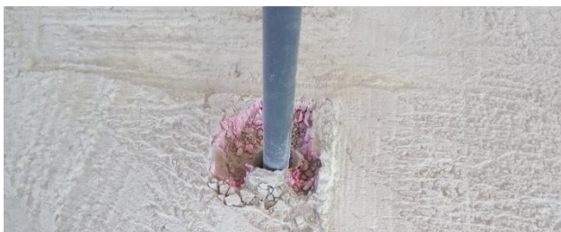
Slika 6. Obrada prodora kroz donju ploču velikog bazena – nepravilan gornji deo otvora i tragovi stirodura
