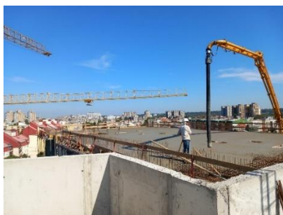
Слика 8. Извођење радова на бетонирању АБ плоча
