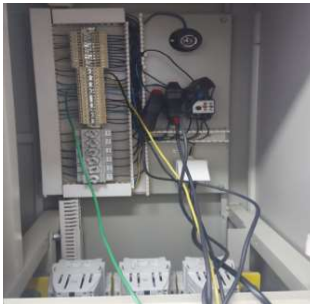
Slika 3. Priključenje uređaja za merenje
