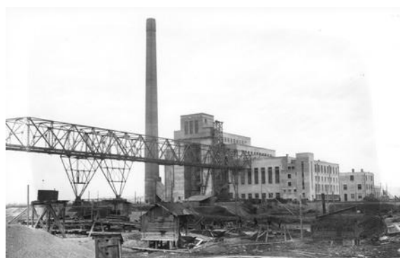
Slika 1. Termoelektrana "Snaga i svetlost" [3].
