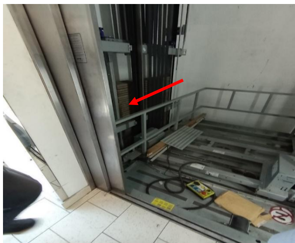
Слика 2. Противтег лифта произвођача „OTIS“, тип „GeN2 Premier“
