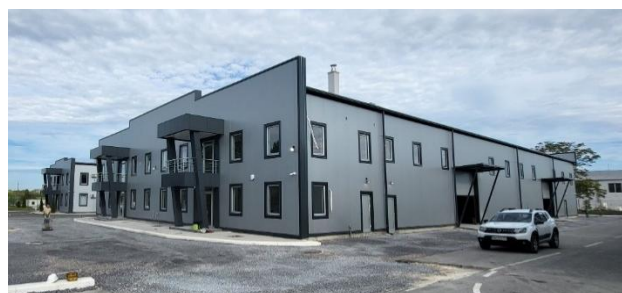
Slika 1. Izgled objekta "Beoinox" – poslovno skladišni deo
