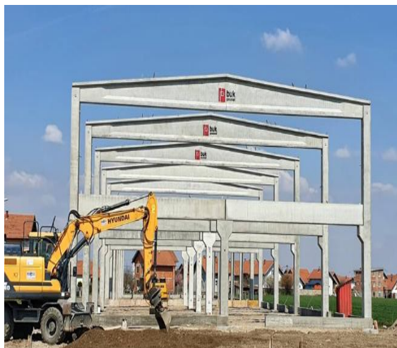
Слика 2. Префабрикациона хала са бетонским елементима у фази очвршћавања [6].
