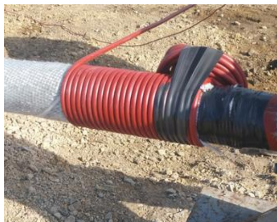
Слика 4. Приказ намотавања индуктивног грејача
