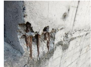
Слика 4. Бетонска гнезда на спољашњој страни фасадног платна
