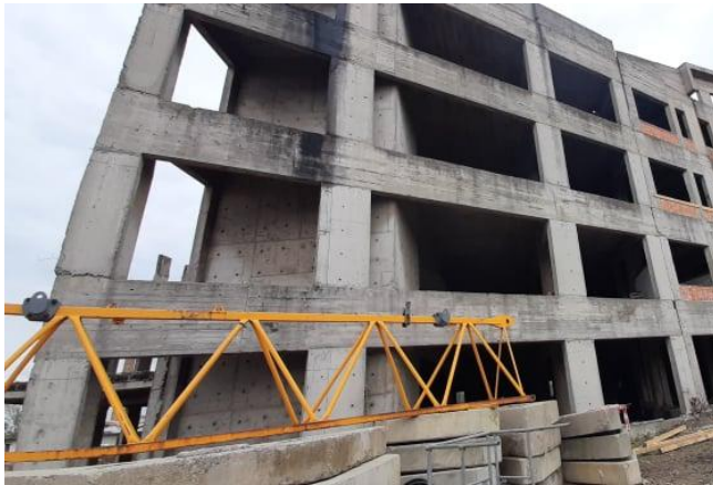
Слика 1. Општи изглед објекта
