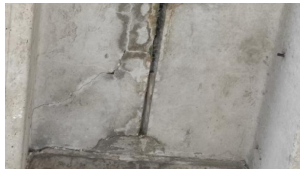
Слика 11. Коса пукотина у углу конзолног дела плоче корубе
