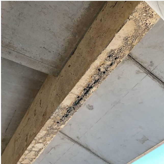
Слика 9. Бетонска гнезда на греди
