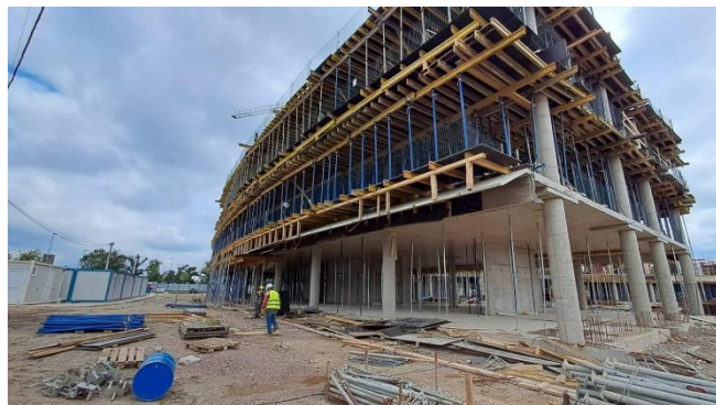
Слика 1. Општи изглед објекта
