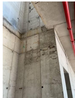
Слика 4. Бетонска гнезда на зидном платну
