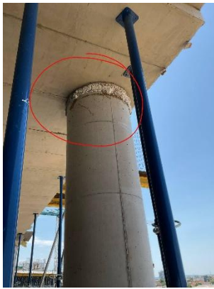
Слика 7. Изглед кружног монолитног стуба, порозан заштитни слој бетона
