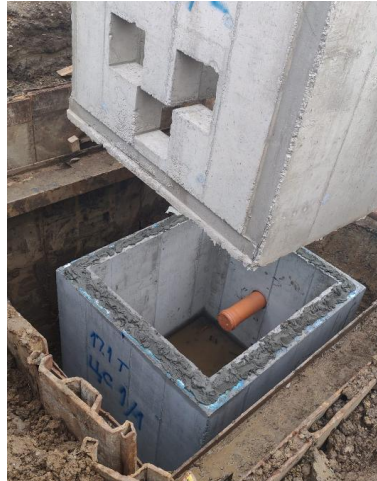
Слика 1. Монтажа елемената црпне станице
