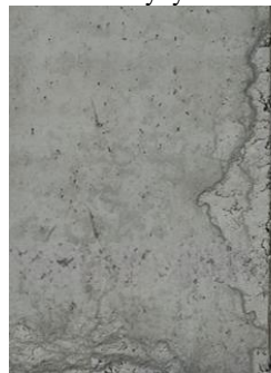
Слика 5. Одломљена ивица стуба, репрофилисана обичним цементним малтером
