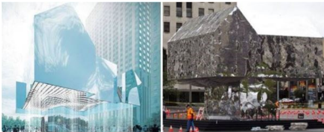
Slika 2. 3D vizualizacija Mark's House (levo); Izgrađeni objekat Mark's House (desno)
