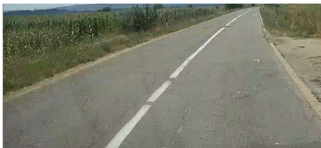
Слика 1: Карактеристична оштећења коловоза на деоници
