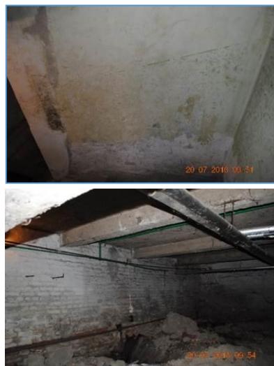
Slika 6. Mrlje od kapilarnog upijanja vlage-zid u osi 3 (gore) i kristalizacija soli u podrumu-zid u osi 2(dole)
