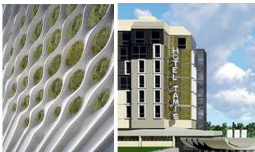
Slike 09 i 10. Bioreceptivni fasadni paneli
