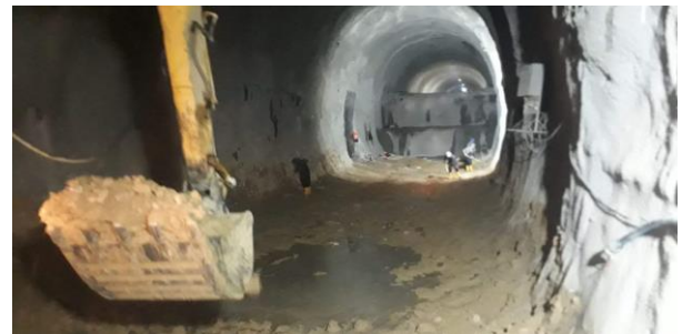
Slika 7. Primarna konstrukcija-završna faza
