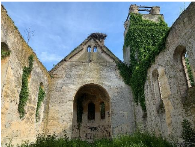
Фотографија бр. 1 Постојеће стање цркве [7]
