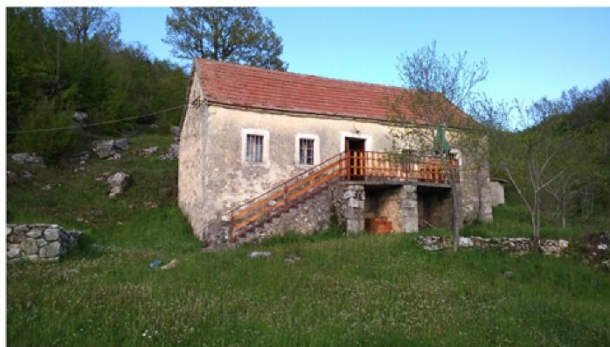
Slika 4. Postojeća lokacija kuće
