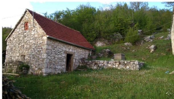
Slika 3. Postojeća lokacija ambara
