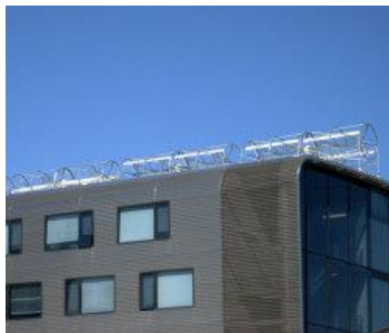
Slika 3. Spiralna Aerotecture turbina na zgradi u Čikagu [2]
