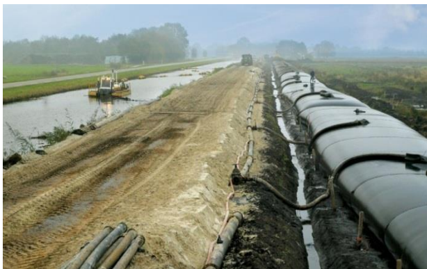
Slika 2. Postavljanje geotekstilnih vreća uz kanal
