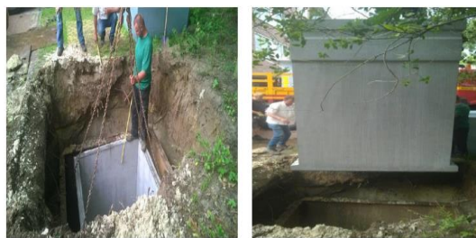
Слика 7. Ископавање рупе у земљишту и постављање бетонске конструкције (Nexus Novus, 2015)
